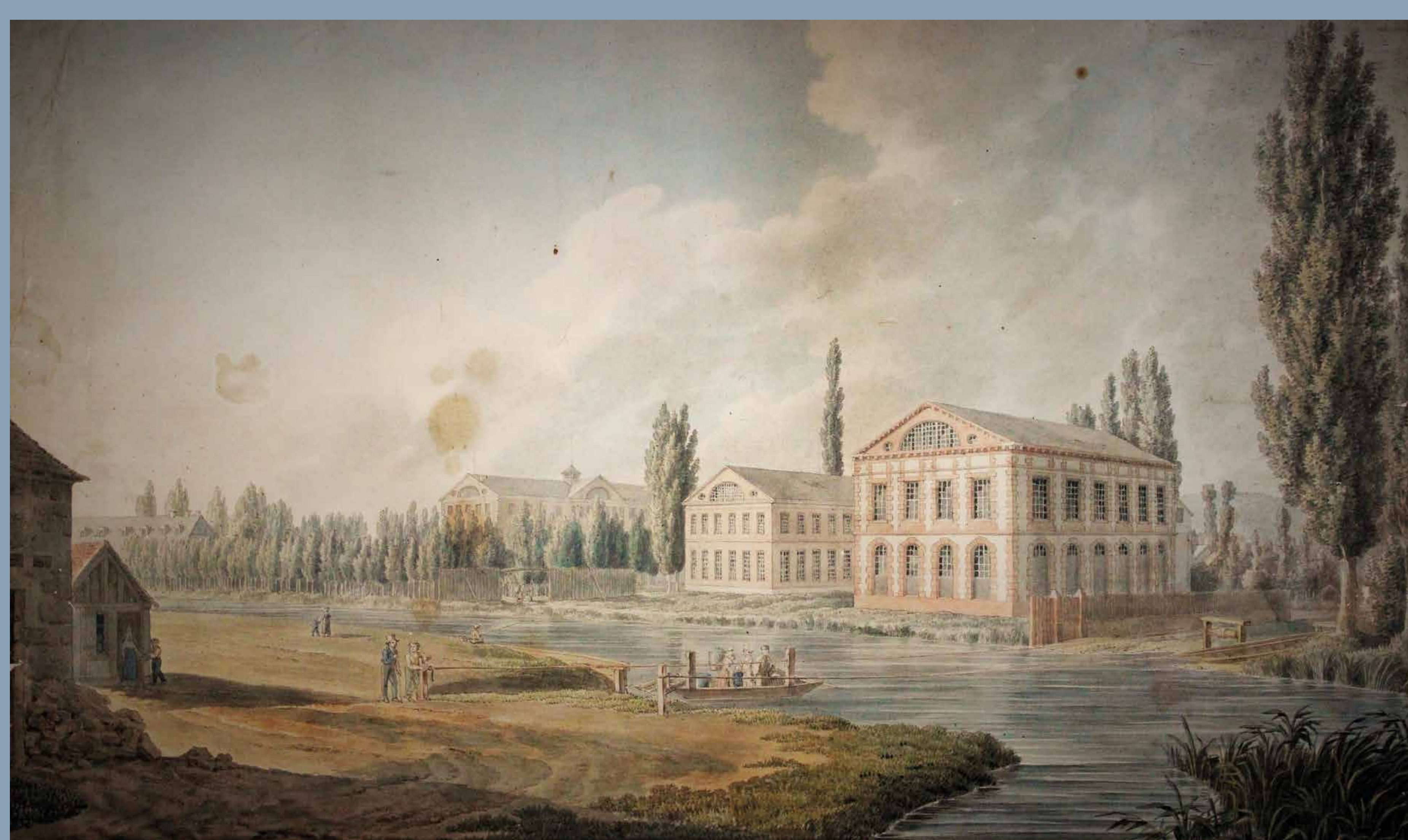
Moulins industriels à Louviers, 1815. AD27.
